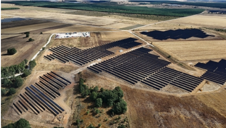
Planea Energía pone en marcha un complejo fotovoltaico de 36 MW de potencia instalada en la provincia de Palencia
