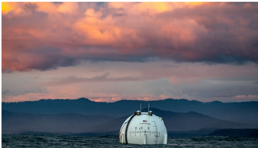
Dispositivo Ocean-2 con esfera gigante generando electricidad con olas en Puget Sound, Estados Unidos.
