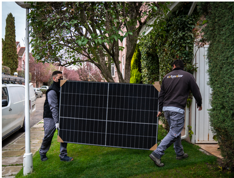
Instaladores de paneles solares de Sotysolar. FOTO: Sotysolar
