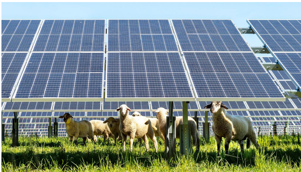
Energía solar fotovoltaica y ahorro eléctrico
