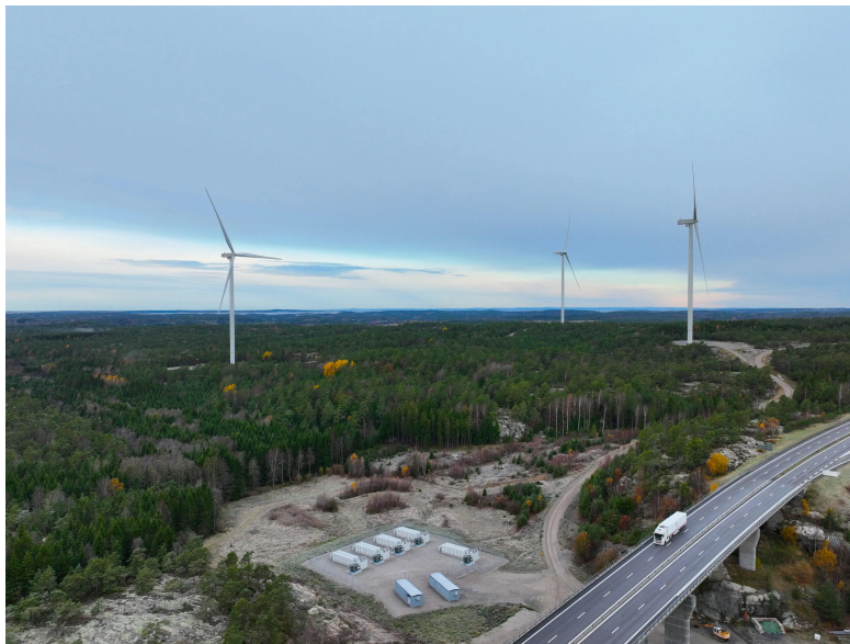
El desarrollador sueco Rabbalshede Kraft obtiene el permiso para la construcción del parque eólico Brattön-Sälelund
