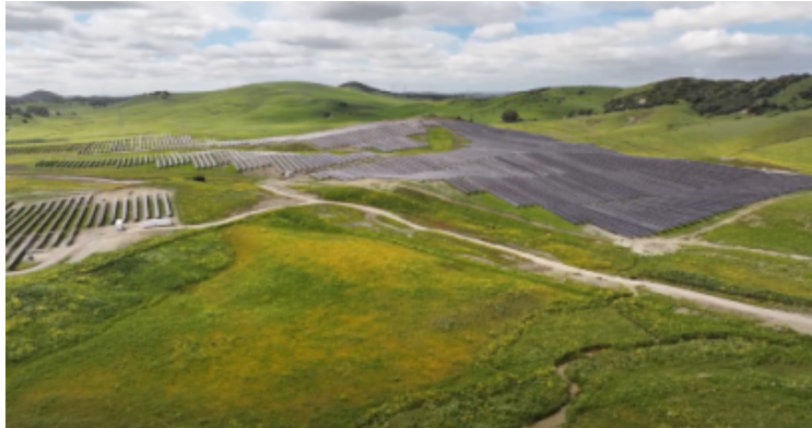
BNZ firma dos nuevos PPAs para dos plantas fotovoltaicas de Cádiz que suman casi 72 MW de capacidad
