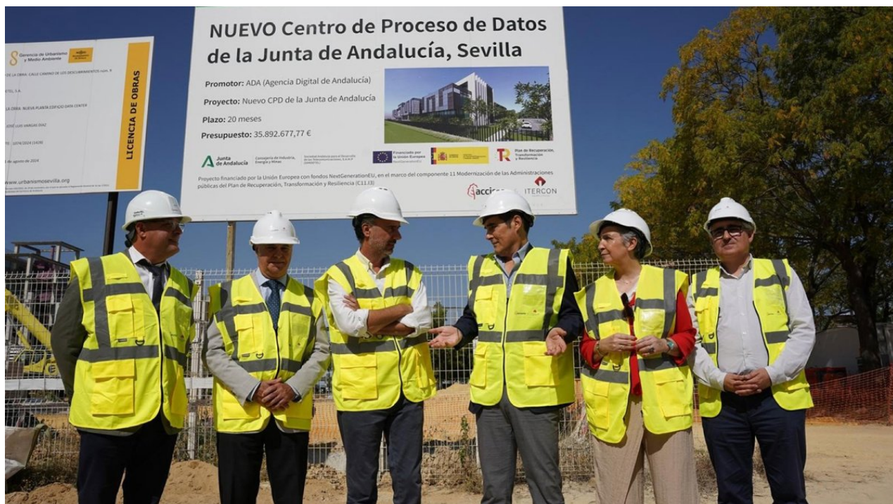
El consejero de Inteligencia Artificial, José Antonio Nieto, visita las obras del centro de datos de Sevilla.
