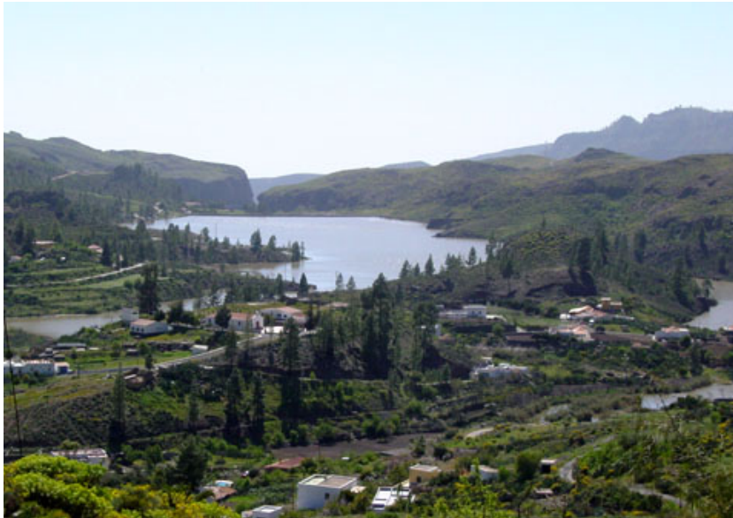
Presa de Chira Soria en Gran Canaria.
