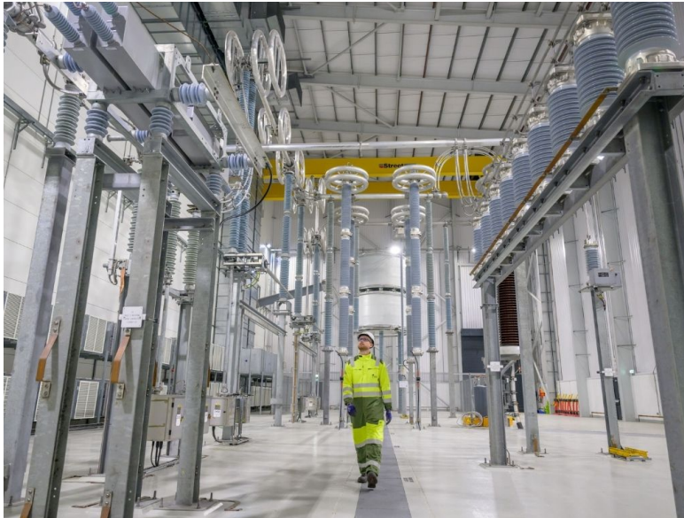
Iberdrola adjudica 2.300 millones a Prysmian para el cable HVDC de interconexión submarina en Reino Unido.
