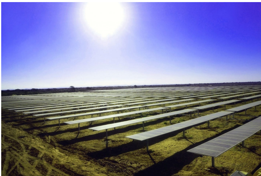
Planta fotovoltaica construida por Acciona.
