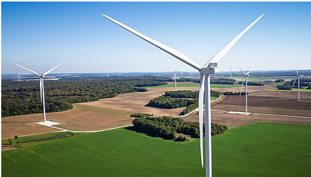
Parque eólico de Q Energy y Velto Renewables en Francia.
