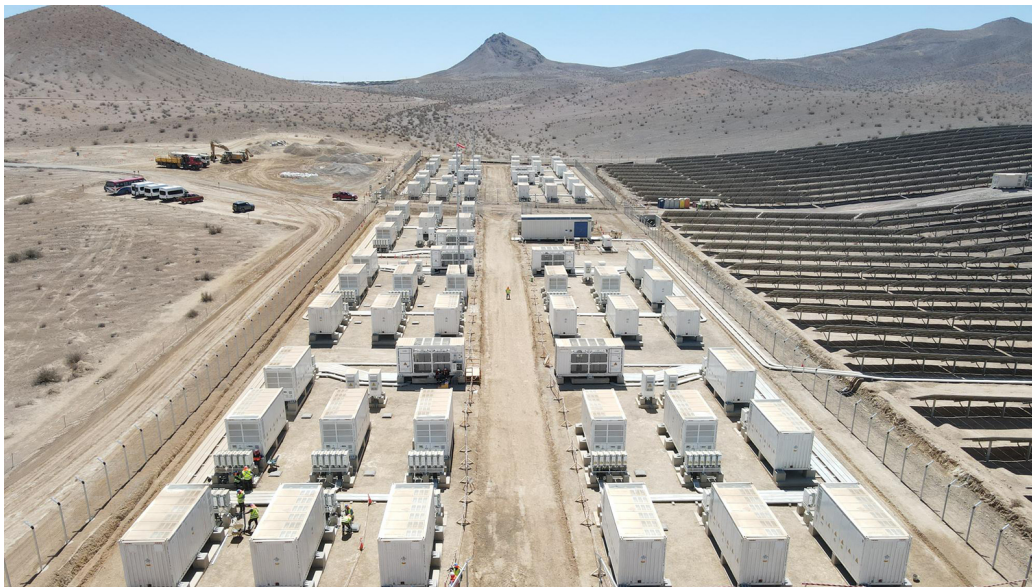
Engie energiza una batería híbrida con un parque fotovoltaico en el desierto de Atacama (Chile).
