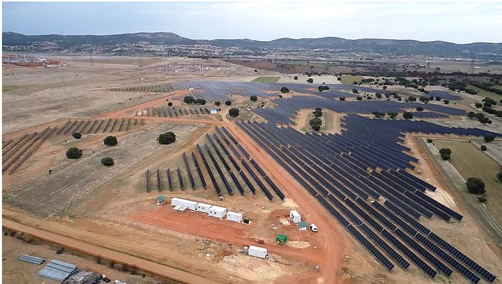
Tesla y Zelestra firman un PPA solar a largo plazo en Texas.
