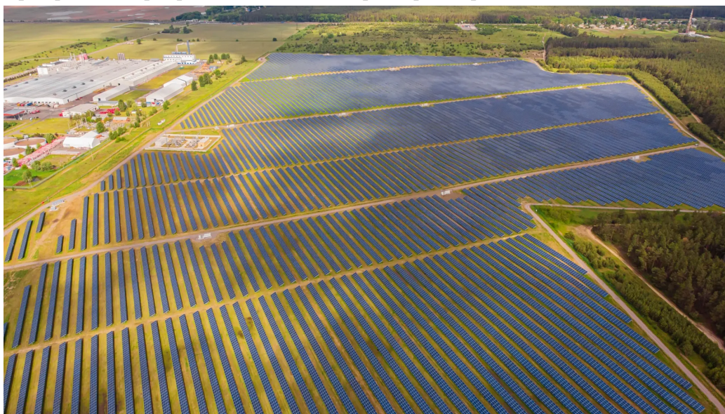
Planta de energía solar fotovoltaica en el campo.
