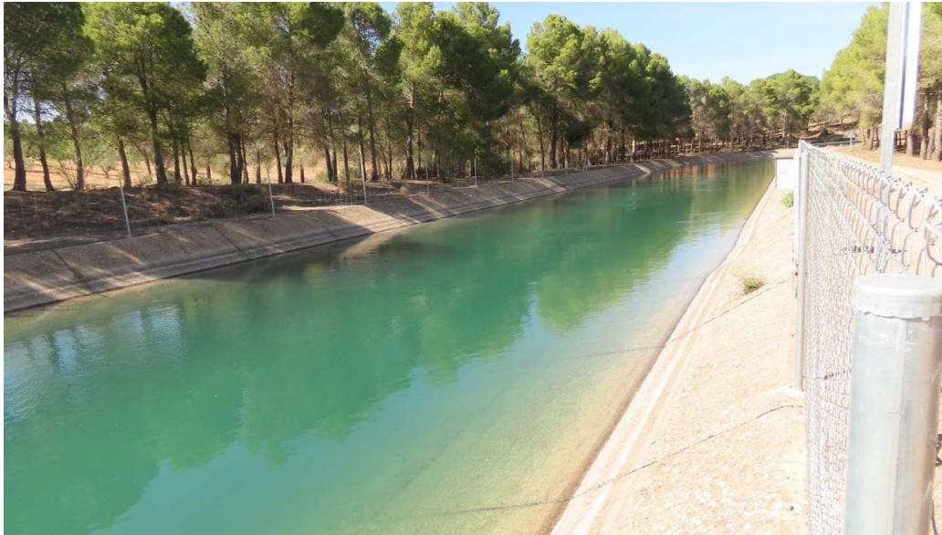
En la imagen el canal del trasvase Tajo-Segura
