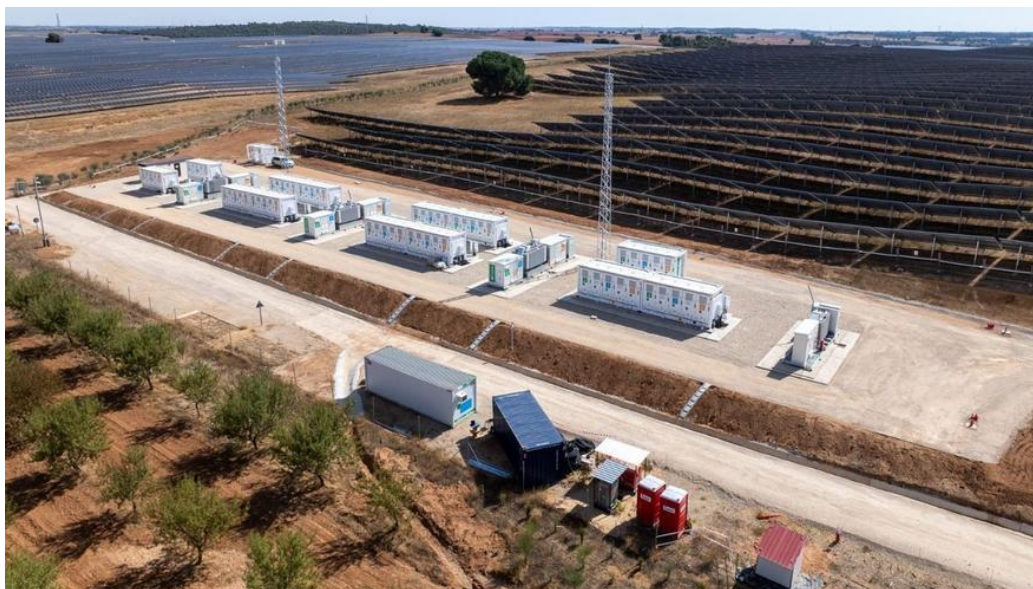
Camp de bateries i d'instal·lacions fotovoltaïques d'Iberdrola a la província de Conca. | IBERDROLA
