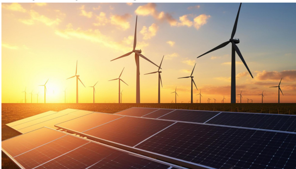
Instalaciones renovables de Enerside.
