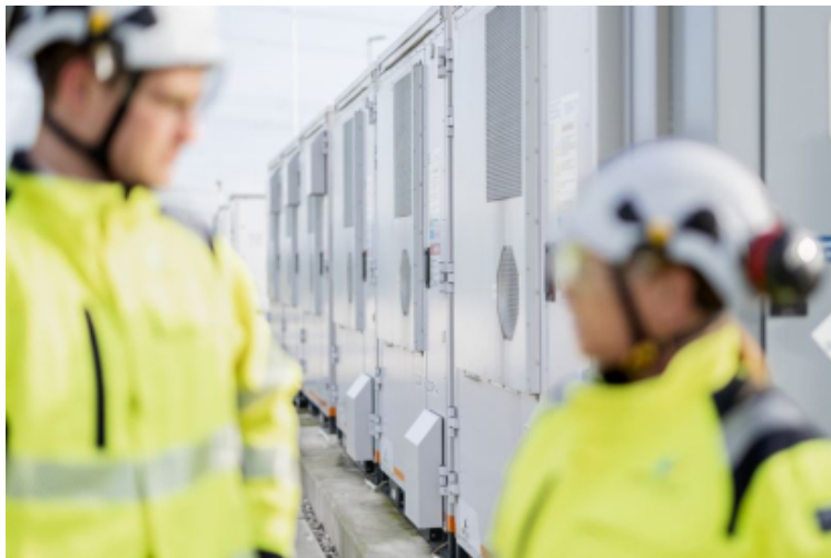
La finlandesa Wärtsilä inicia la construcción de un sistema de baterías de 50 MW en Bélgica
