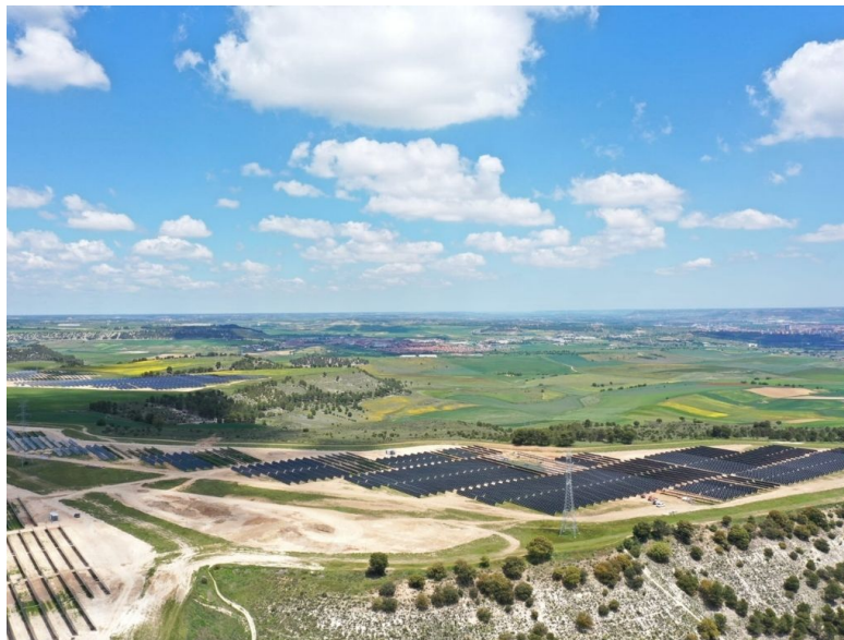
IASOL finaliza un parque fotovoltaico de 39 MWp en Valladolid que producirá 75.000 MWh al año.
