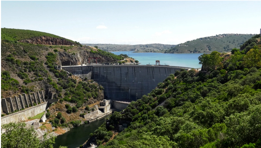
Iberdrola recibe la autorización administrativa para su proyecto de bombeo de Valdecañas (Cáceres).
