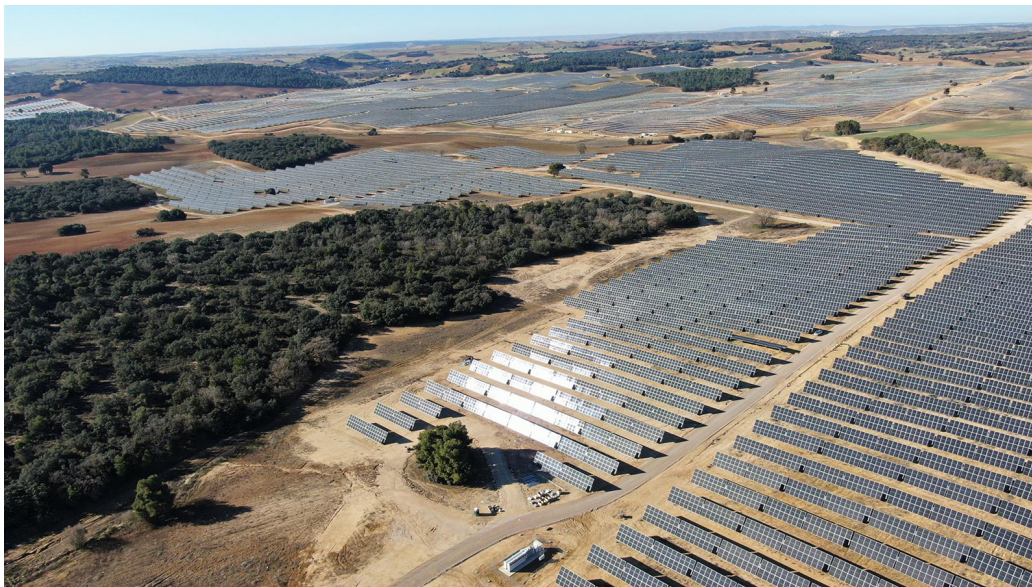
Planta solar de Greenergy.
