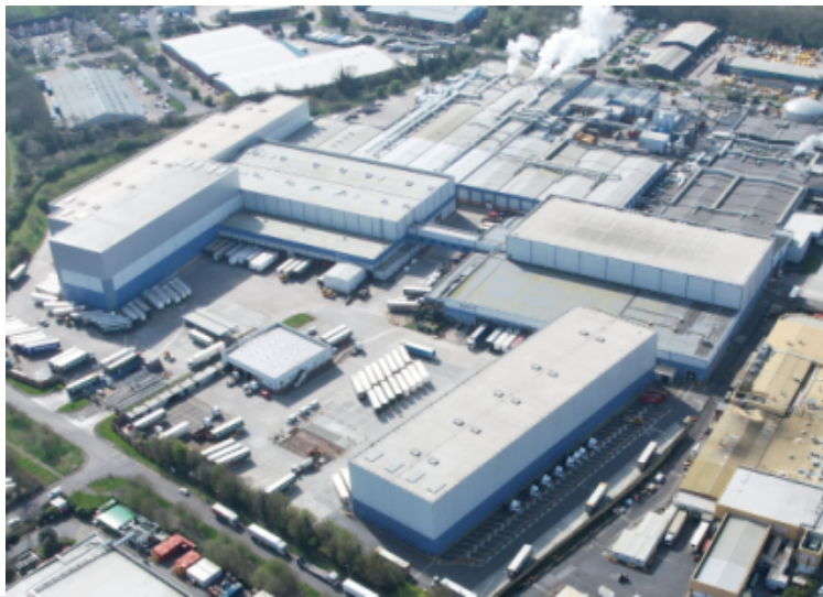
PepsiCo tendrá una instalación fotovoltaica sobre cubierta en su fábrica de Leicester
