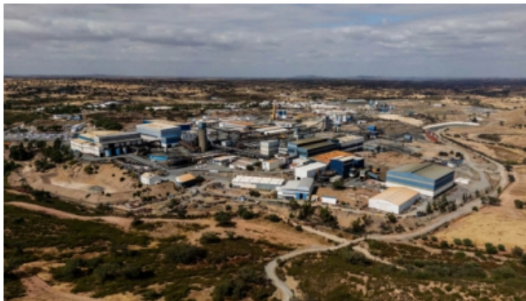
El autoconsumo llega hasta la mina de zinc de Neves-Corvo en Portugal
