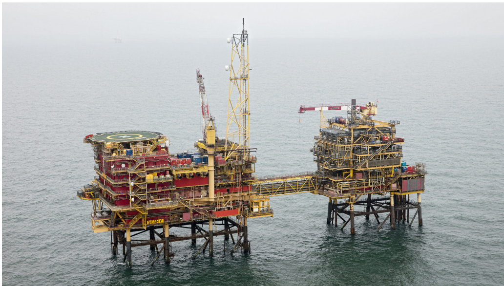
Instalaciones de ONE-Dyas.
