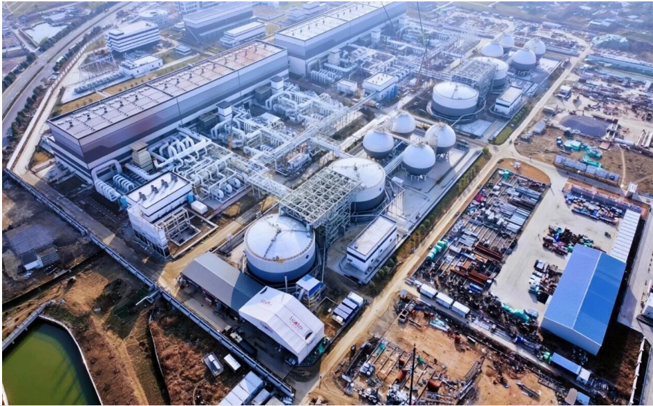
La mayor instalación de almacenamiento de energía por aire comprimido del mundo entra en funcionamiento en cavernas de sal en China
