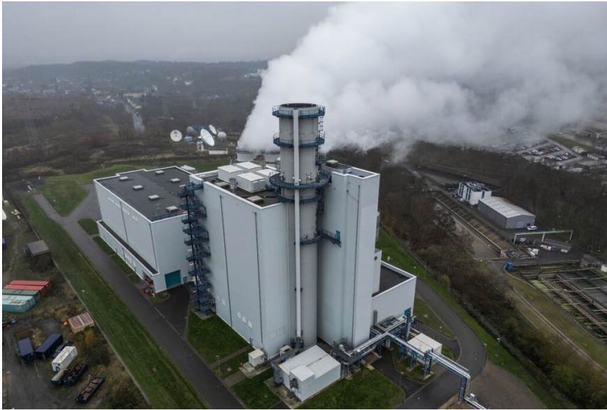
Alemania aprueba una ley para subvencionar nuevas centrales eléctricas de gas, por lo que las subastas serán más costosas
