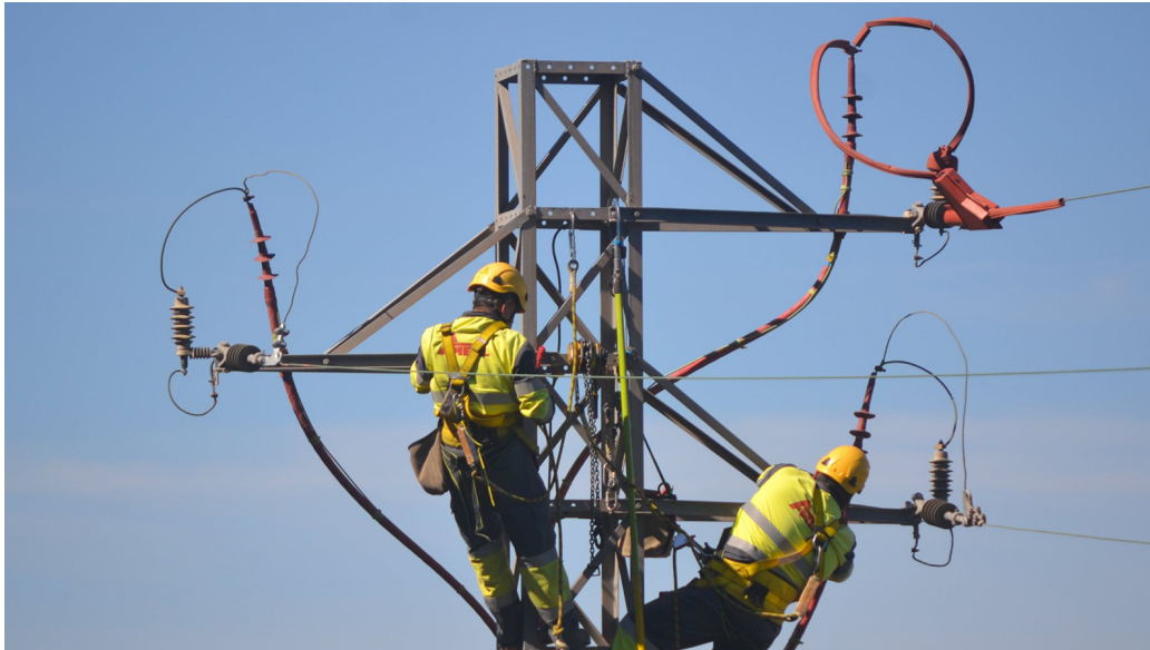
Endesa adecúa 4.200 apoyos de los tendidos aéreos para proteger a la avifauna.
