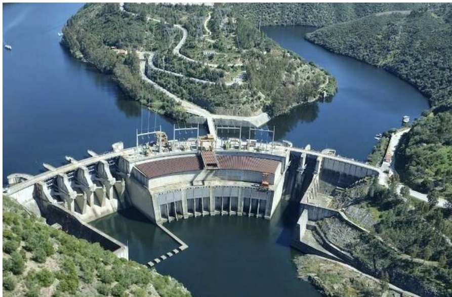
Central hidroeléctrica de Cedillo, propiedad de Iberdrola.
