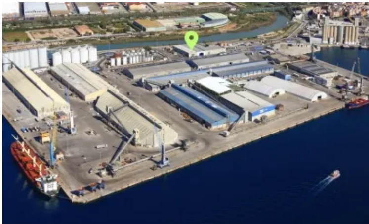
El Puerto de Tarragona impulsa una planta solar de 600 kW, su mayor proyecto autoconsumo
