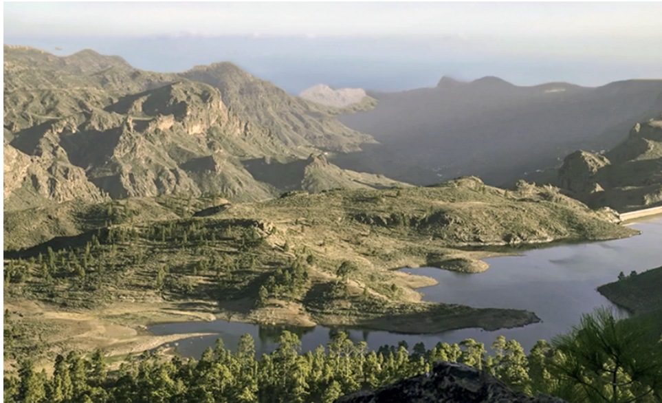
Central de bombeo de Chira-Soria de REE en Gran Canaria.
