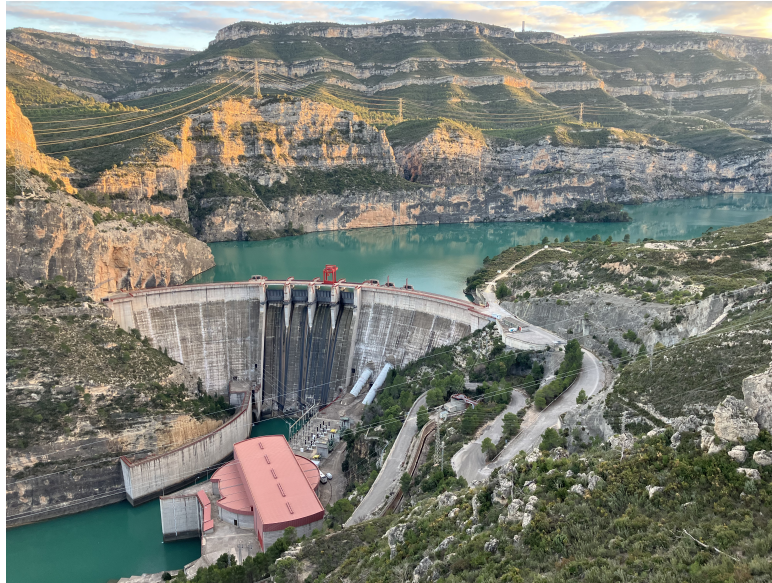
Central de bombeo Cortes-La Muela en la provincia de Valencia.
