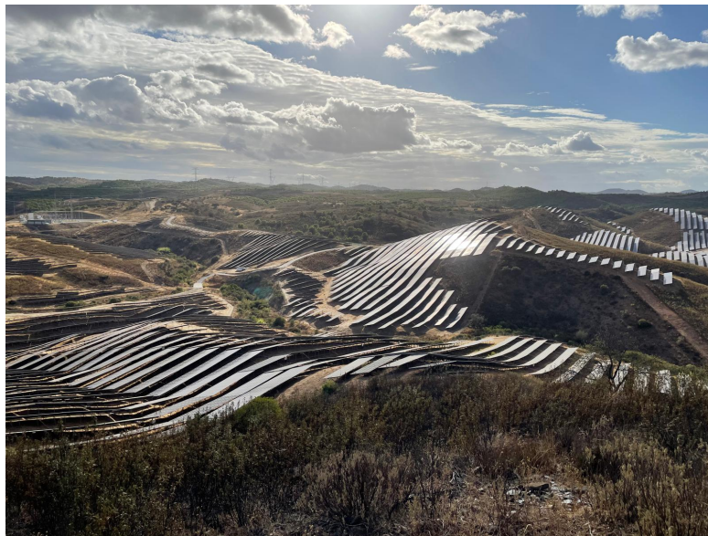
Portugal avisa: la mayor planta fotovoltaica en tierra lusa, en quiebra por los escasos ingresos
