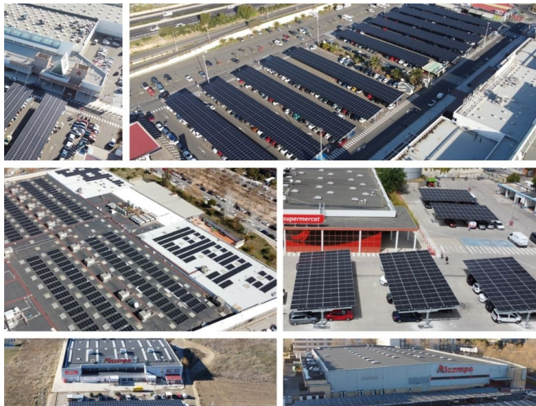
Helexia suma siete nuevas instalaciones fotovoltaicas con Alcampo en 2025, con 4 MWp adicionales.
