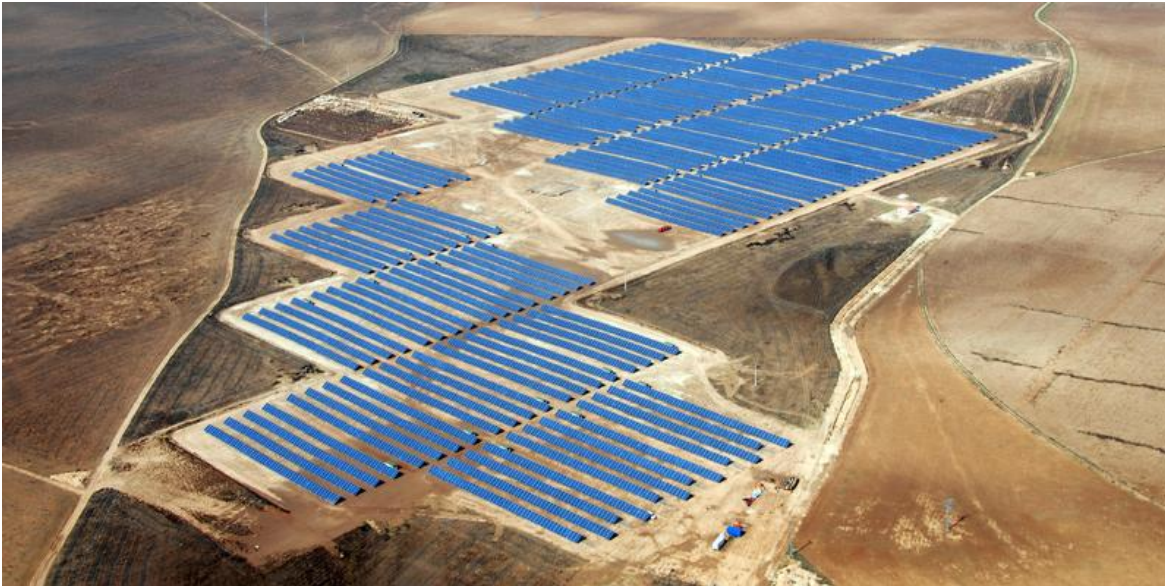
Parque fotovoltaico de Renovalia.
