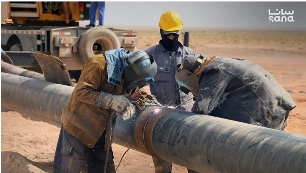
quipos técnicos de la Compañía Siria de Petróleo trabajan en la reparación del gasoducto de Al-Jabsa en Deir Ezzor.
