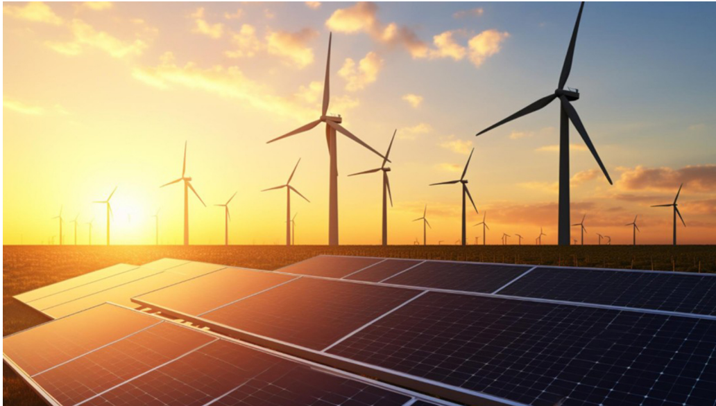
Instalaciones renovables de Enerside.
