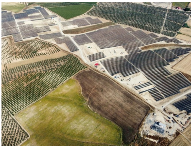
Solarig conecta a la red “Arco 8”, su séptima planta solar en Andalucía.
