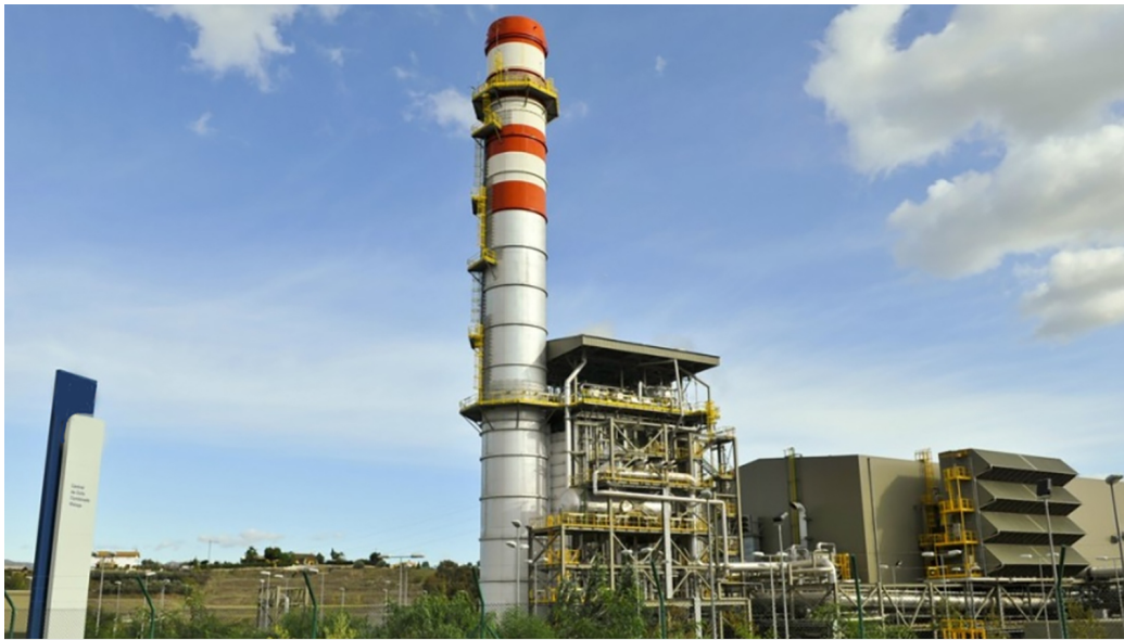
La central de ciclo combinado de Palos de la Frontera (Huelva) de Naturgy.
