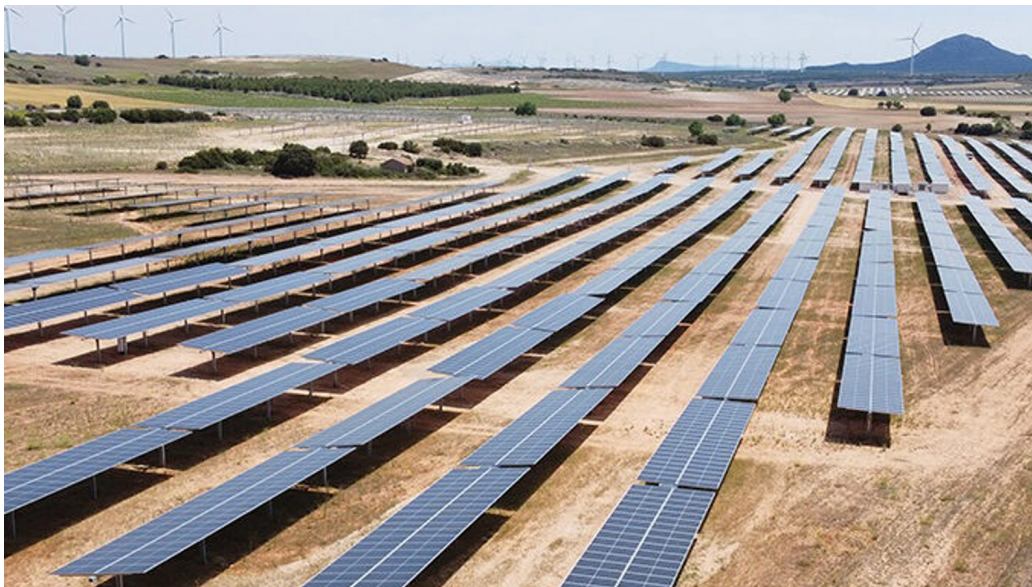
Proyecto solar de Elawan Energy.
