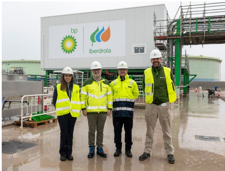
La planta de hidrógeno verde de Bp e Iberdrola en Castellón alcanza el 90% de construcción.
