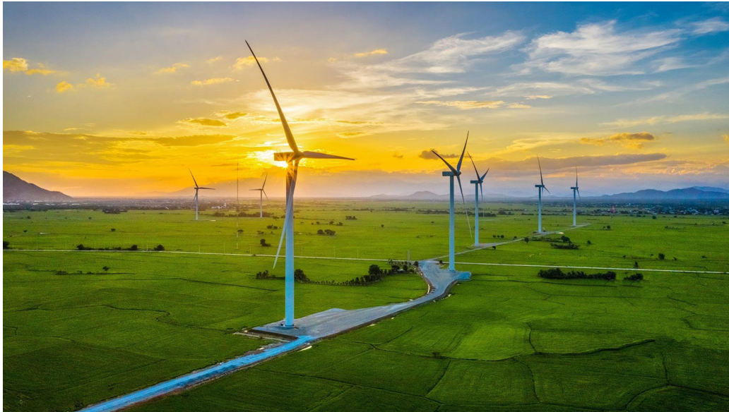
Parque eólico de Siemens Gamesa en Vietnam.
