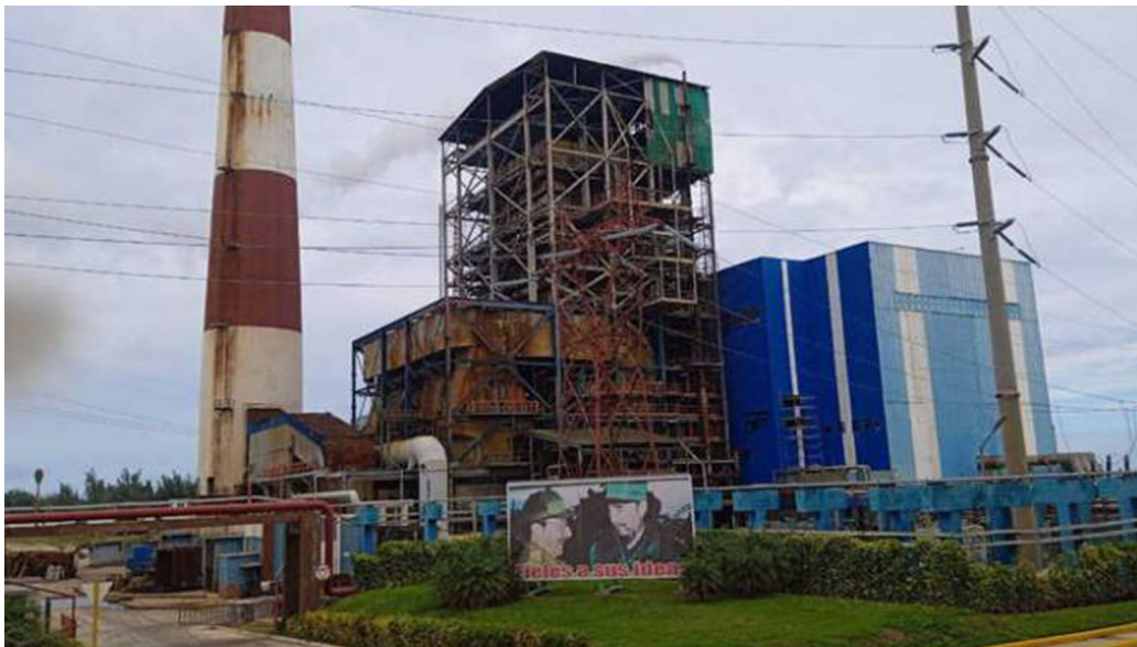
Central termoeléctrica de Guiteras, en Cuba.
