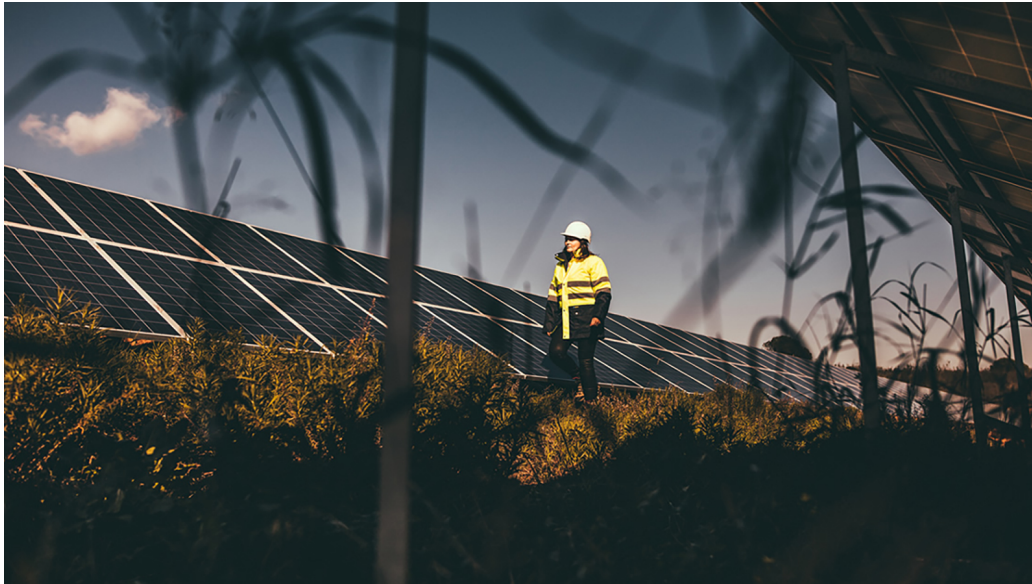
Parque solar de Galp.
