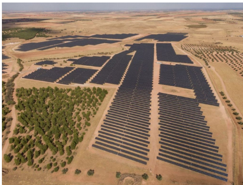
Aquila Clean Energy Manztierra Ciudad Real BESS
