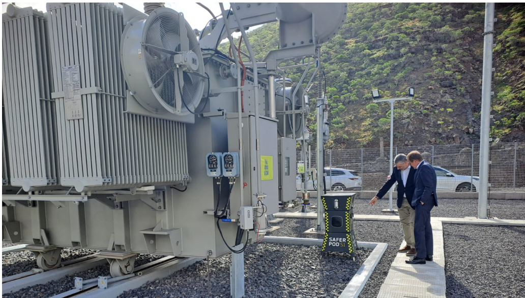
Endesa construye en tiempo récord la nueva subestación El Palmar, que transformará la energía del cable submarino Tenerife-La Gomera.
