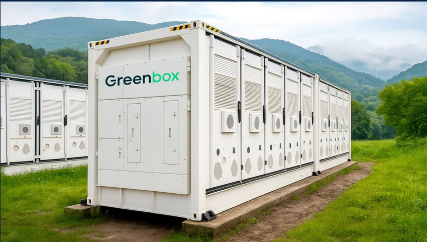
El Gobierno autoriza la construcción de cuatro baterías a Grenergy en sendos parques fotovoltaicos en Cuenca
