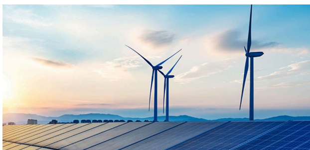
Aerogeneradores junto a un parque solar. iStock
