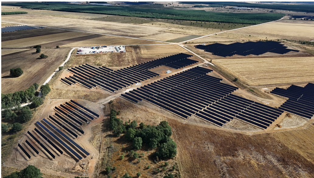
Planea Energía pone en marcha el complejo fotovoltaico Velilla de 36 MWp de potencia en Mantinos (Palencia)
