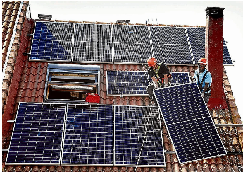
Operarios trabajan en la instalación de placas fotovoltaicas.
