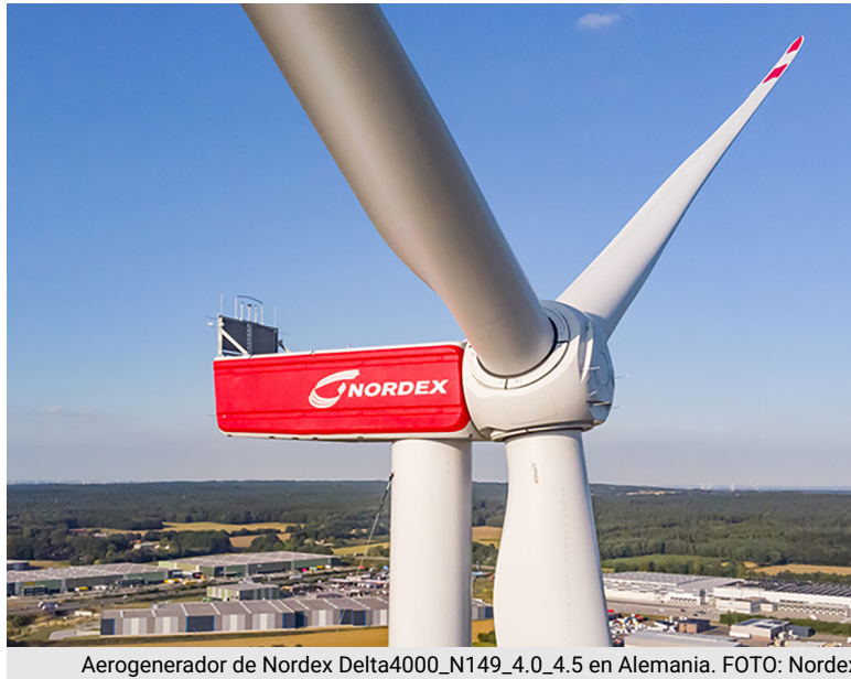
Aerogenerador de Nordex Delta4000_N149_4.0_4.5 en Alemania. FOTO: Nordex
